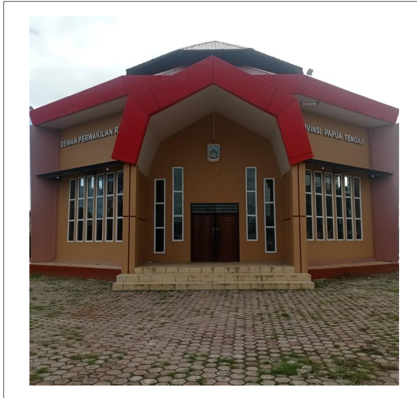
Gambar 2. Gedung Sekerretaris Dewan DPRP Papua Tengah
